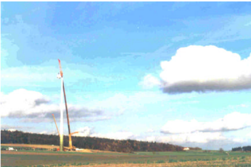
Windmühle bei Unterriffingen während des 2-tägigen Aufbaus im November 2000 Foto: gw
